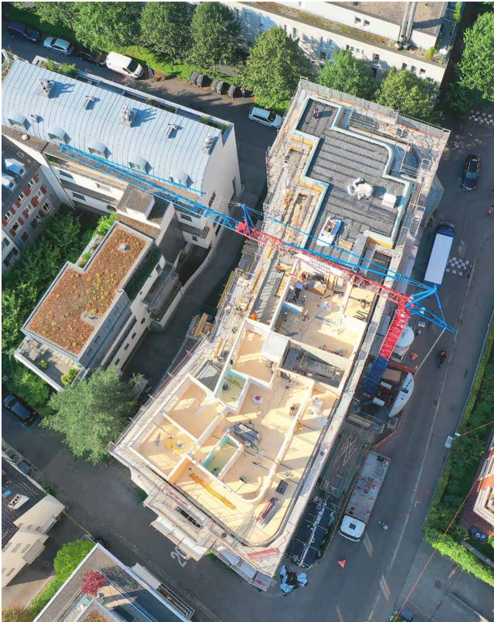
Mitten im Zürcher Seefeld entstanden auf einem Mehrfamilienhaus in kürzester Zeit gleich vier neue Wohnungen in Holzbauweise. BILD DIDECO AG
